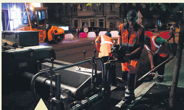
Щоб мінімізувати незручності для киян, ремонт багатьох вулиць у центрі міста здійснювали в нічний час. На фото — Ярославів Вал: новий асфальт, тротуари, освітлення.
