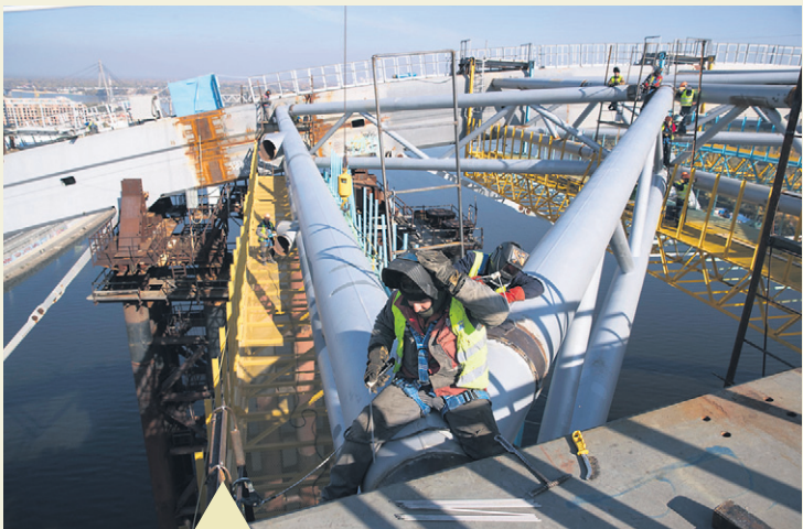
Встановлення верхніх зв'язок на Подільсько-Воскресенському мосту. Вже наступного року, коли монтаж завершать, будуть прибрані опори, що підтримують конструкцію. Активно тривають роботи і на інших ділянках проекту.
